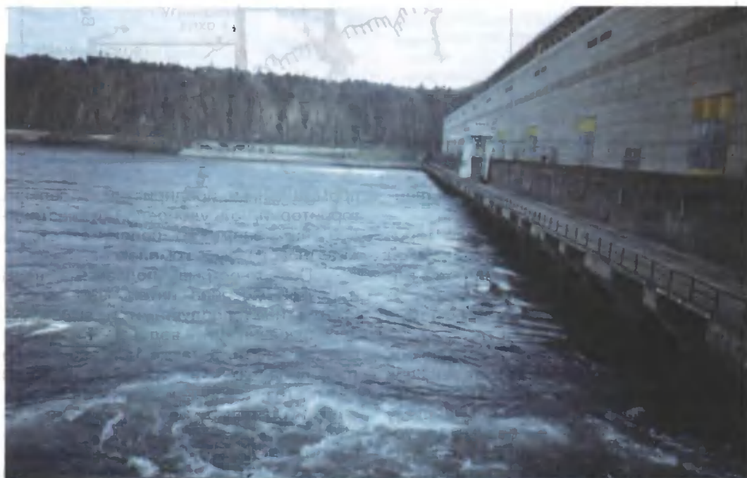
Вид на плотину с нижнего бьефа.
